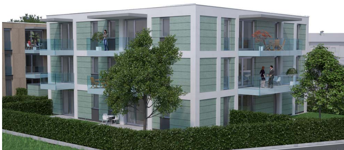
Abbildung 3: Demonstrationsgebäude –Holz Hybridbau, Bernhofer Gründe in Kuchl (Quelle: Studio b&f Planungs OG)
